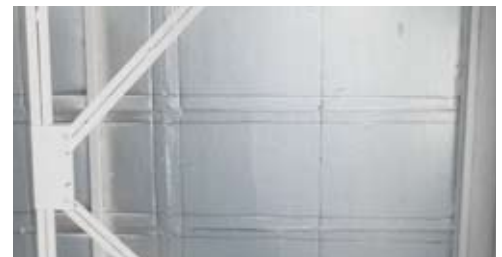
Εμφανής εσωτερική μόνωση μεταλλικού δώματος με FIBRANgeo B-570-AX
