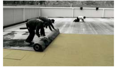
Μεταλλικό δώμα με στεγανοποίηση μεμβράνης πάνω σε διπλή στρώση FIBRANgeo BP 40
