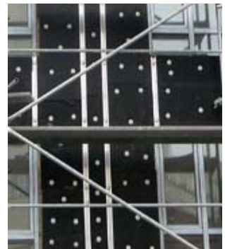
Λεπτομέρεια αεριζόμενης όψης με FIBRANgeo B-570-YM
