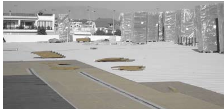
Μεταλλικό δώμα με διπλή στρώση από FIBRANgeo BP 50 + BP 70
